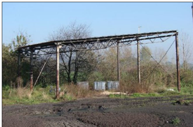
Wiata magazynowa osadu odwodnionego – stan obecny
