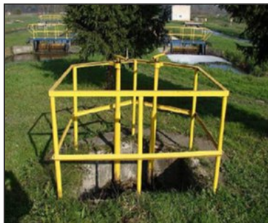
Komora rozdziału 2 - stan obecny
