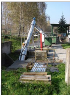
Kanal dopływowy z sitem - stan obecny
